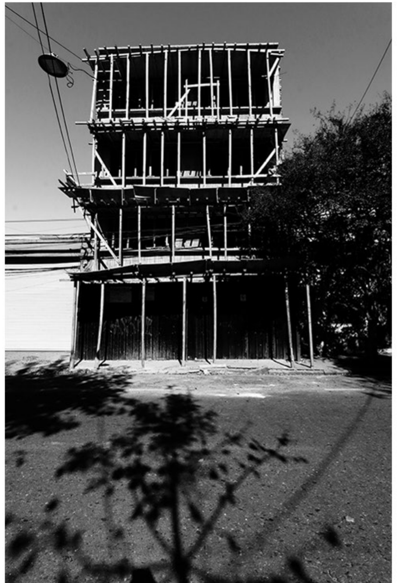
Construcción. Rosario, Santa Fe, Argentina.
