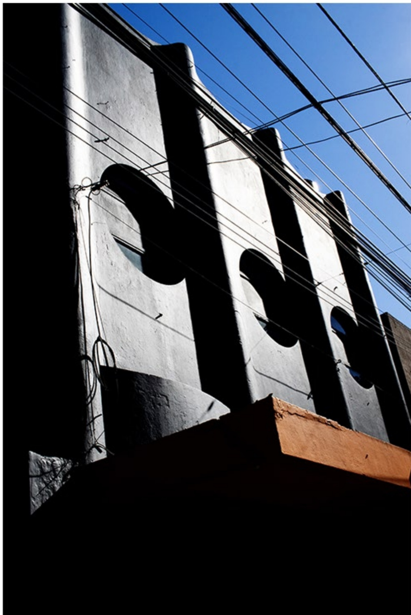
Fachada. (Ex-Cine Gardel). Rosario, Santa Fe. Argentina.
